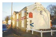
Fachada após limpeza com Cleanwall
